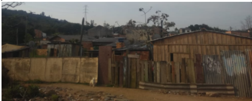
Figura 3: Trecho do muro que divide uma área de expansão irregular da Vila Esperança de uma área fronteira da Vila União.
